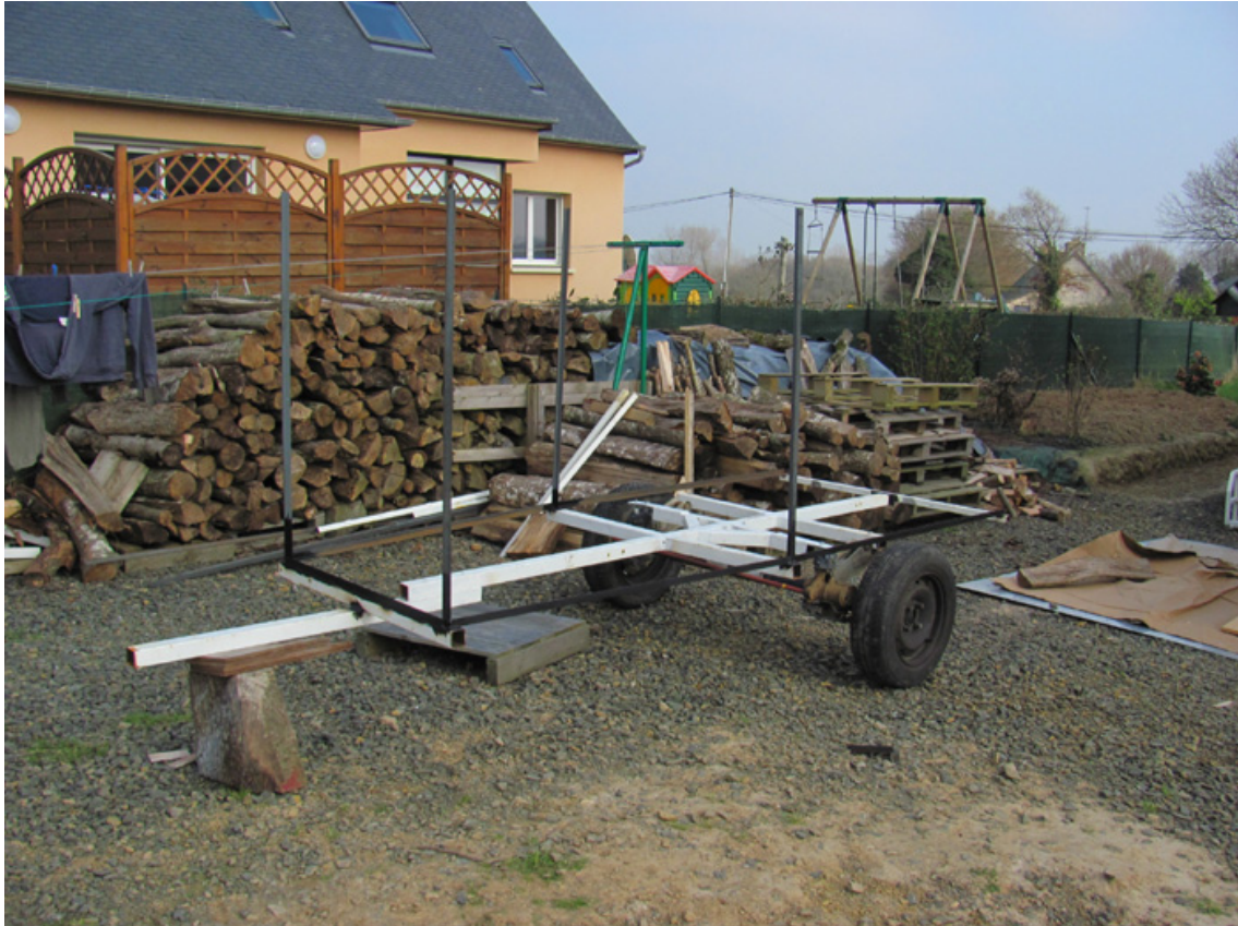
Cinquième étape, je découpe et soude une plaque acier galvanisée épaisseur 1.5mm pour le fond de la remorque
